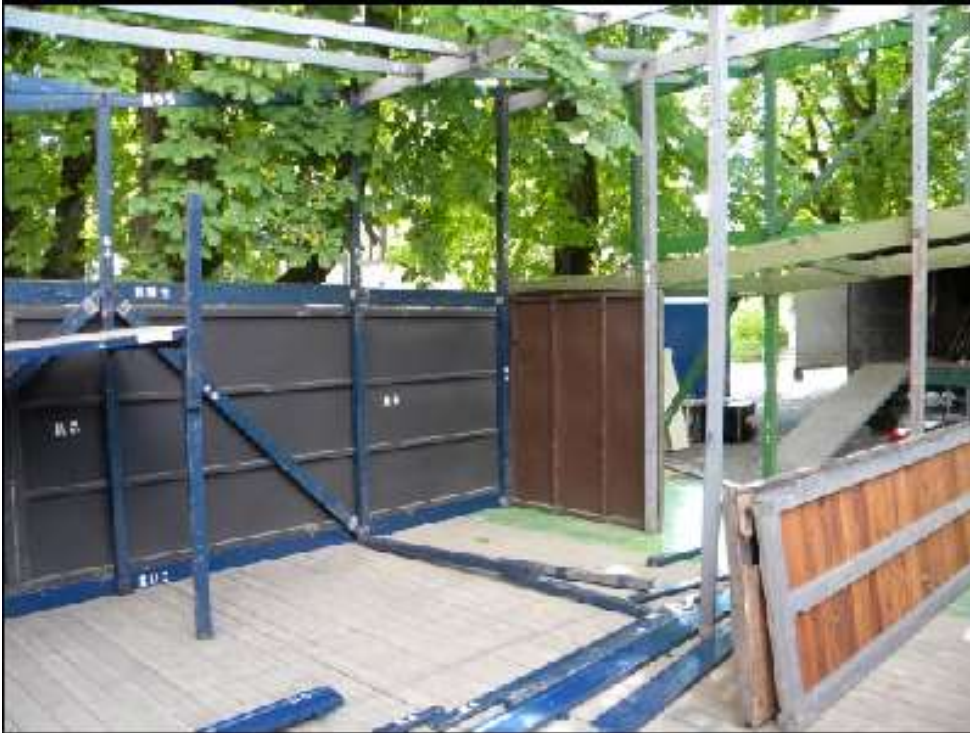
Einsetzen der Wände
