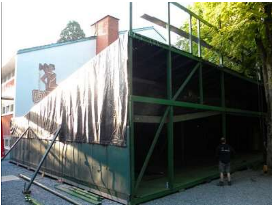
Das Anbringen der Planen, die nicht nur das Dach, sondern auch einen Teil der seitlichen Wände überdecken.
