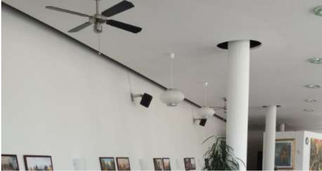
Unterzug. Ehem. Rest. Spice India, Nordbrücke 4, 8037 Zürich
