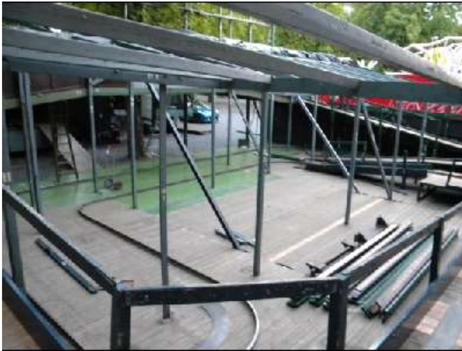
Verlegen der Schienen
