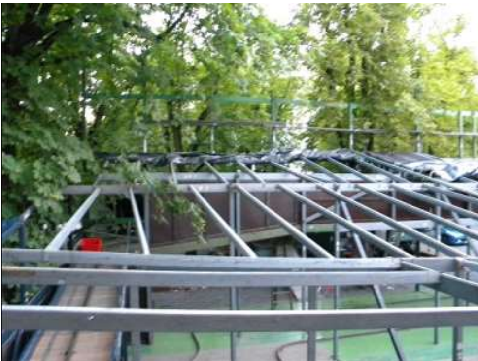
Errichtung der Dachkonstruktion, die später durch Planen abgedeckt wird.
