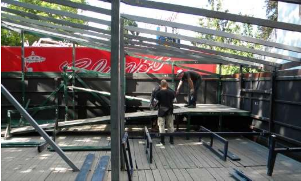
Drehabsatz für die Gondeln (Wagen) bei bidirektionaler Abfahrtsbahn. Wiener Prater-Geisterbahn (Photo: Pascal Steiner)
