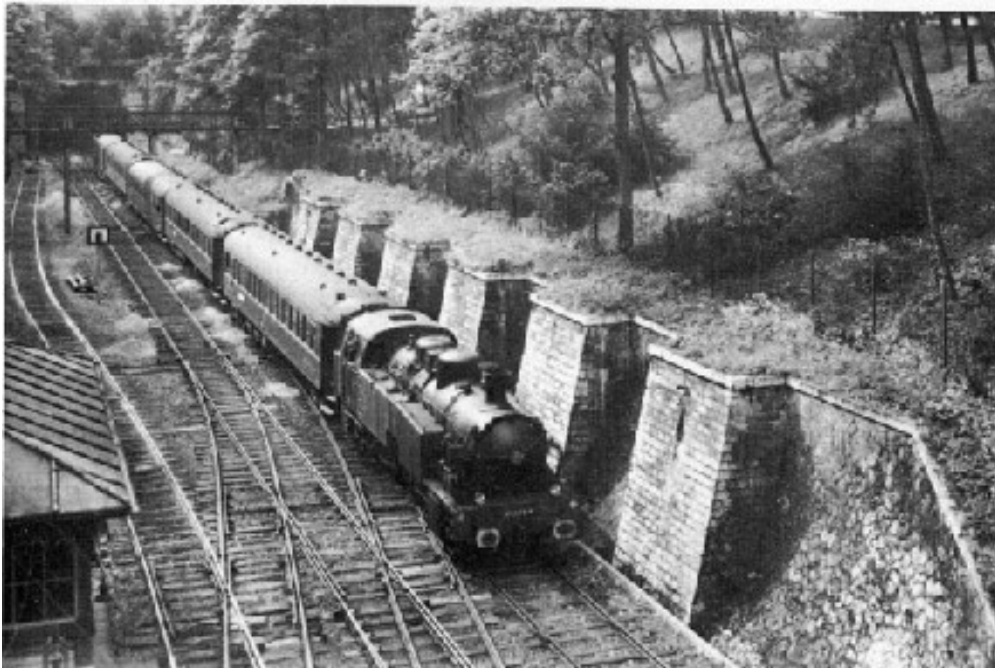
Gare Ménilmontant der Chemin de Fer de Petite Ceinture
