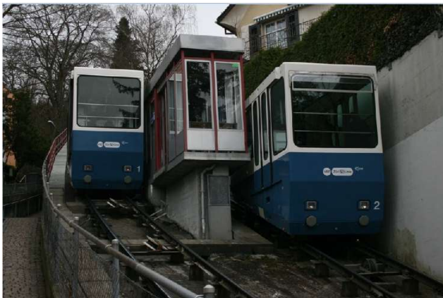
(Stand-)Seilbahn Rigiblick, 8006 Zürich
